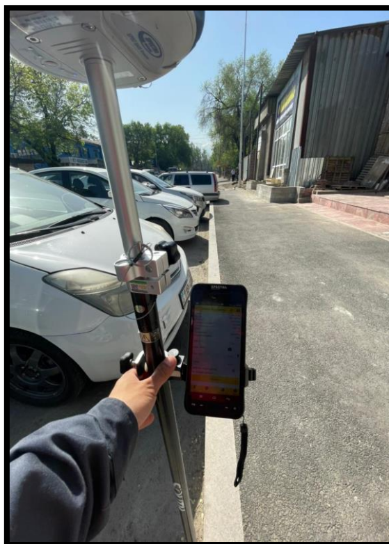
А5 Сурет - ГНСС қабылдағыштың көмегімен төселген асфальт жабынына атқарымдық түсіріс орындау барысы
